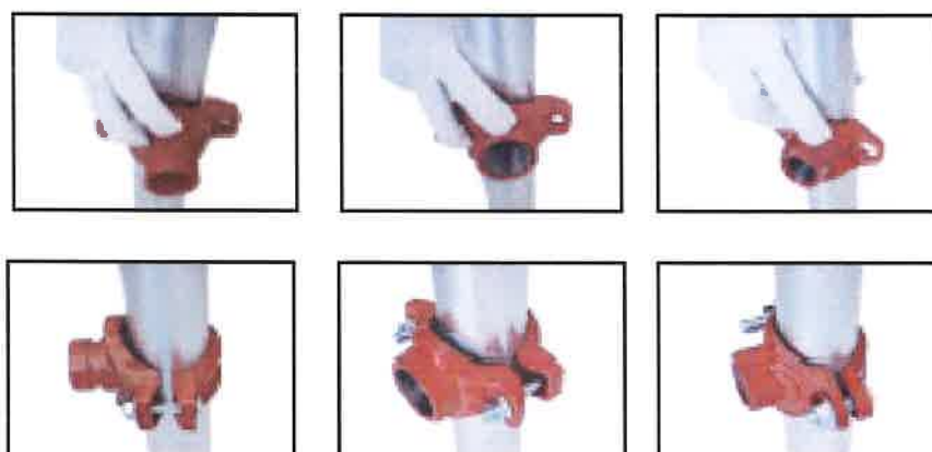
Rys. 2. Sposób instalowania króćca na przewodzie rurowym
